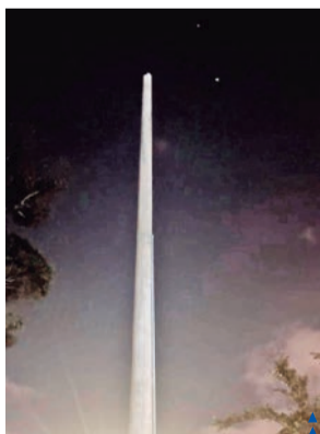
Imagen tomada antes de la reparación de las luminarias.
