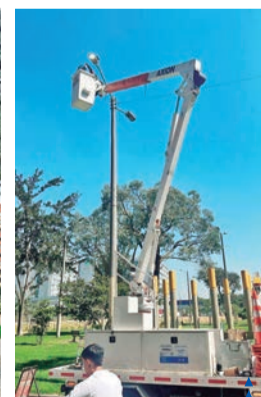
Resultado de la reparación de luminarias
