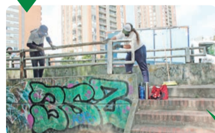
Lijado para eliminar óxido y tierra de las barandas
