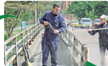
Hidrolavado y lijado para eliminar óxido y tierra de las barandas
